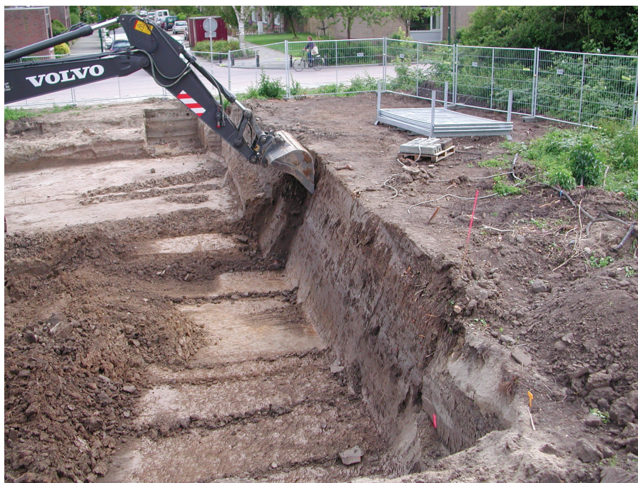
Fig. 4.3: Machinale aanleg van profiel 16.
